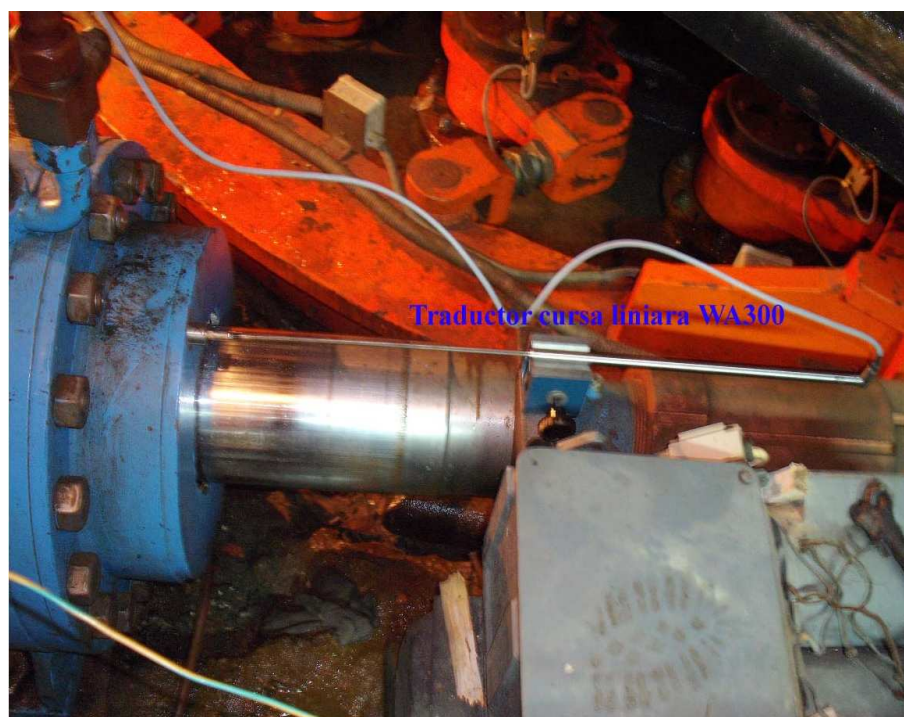
Fig. 10 Măsurarea cursei liniare a pistonului de acționare
